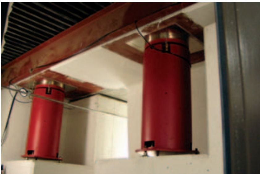
Tyto baryle drží pokusné místnosti princetonské fyzikální laboratoře na vzduchovém polštáři, izolované od pohybů Země. Dalším vlivům vnějšího prostředí brání zvukotěsné dveře.
