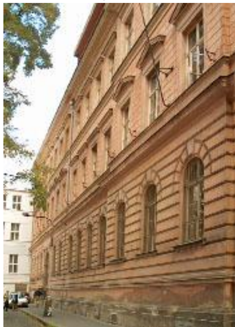
budova Pedagogické fakulty UK v ulici M. D. Rettigové 4, Praha 1
