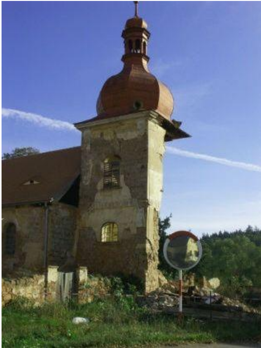
RNDr. Silvie Kučerová, Katedra sociální geografie a regionálního rozvoje Zrcadlo, pověz, jsem nejkrásnější? – kostel ve vsi Vidhostice u Vroutku pobořený v důsledku havarijního stavu a průjezdu těžké techniky, fotodokumentace stavu fyzického prostředí, hospodářsky slabá periferní oblast postižená odsunem českých Němců po 2. světové válce, modelové území grantového projektu. Kategorie: Modelování struktur
