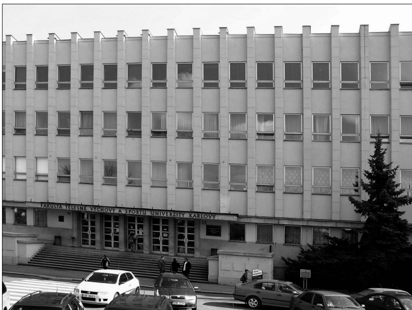
„Nová“ budova FTVS UK ve Veveřslavíně
